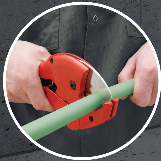
01 | 用切管器裁剪管道。
